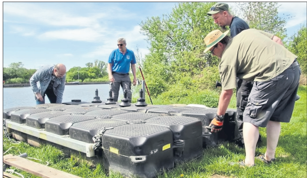
Mitglieder des Segelvereins bringen einen neuen schwimmenden Steg in Position. Am stationären Metallsteg ist das Wasser nicht für alle Boote tief genug.
